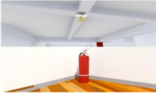
**Gambar 22. Penempatan sprinkler dan alat pemadam dalam bangunan**
